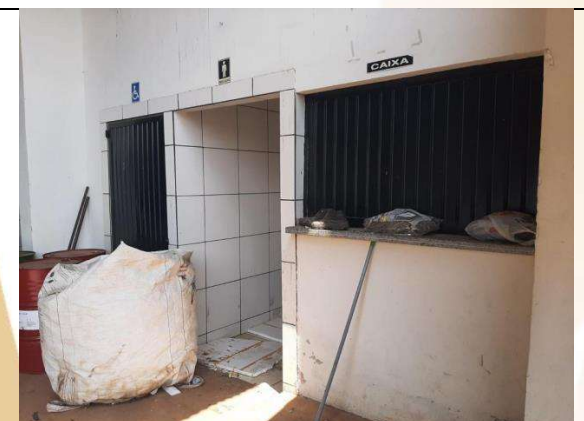
Imagem 13 – Visita “in loco”.
