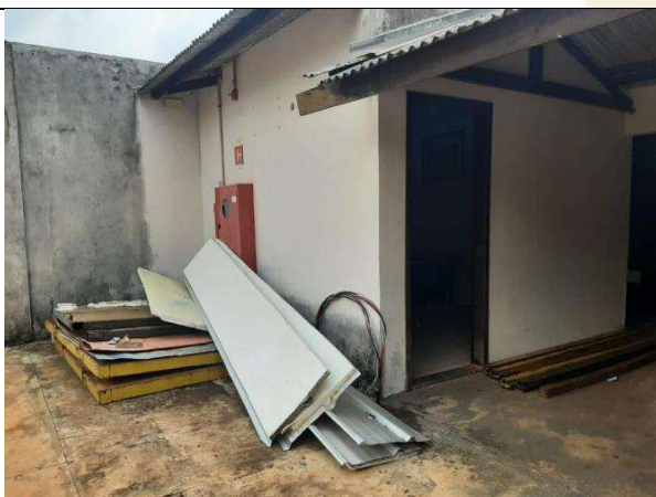
Imagem 05 – Visita “ in loco ”.
