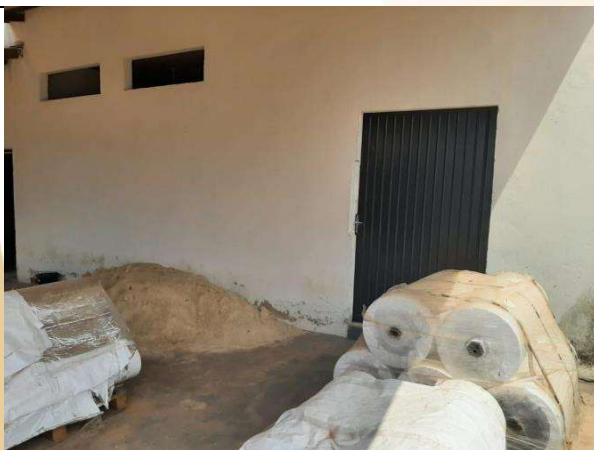
Imagem 07 – Visita “ in loco ”.
