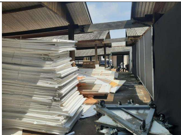
Imagem 09 – Visita “in loco”.
