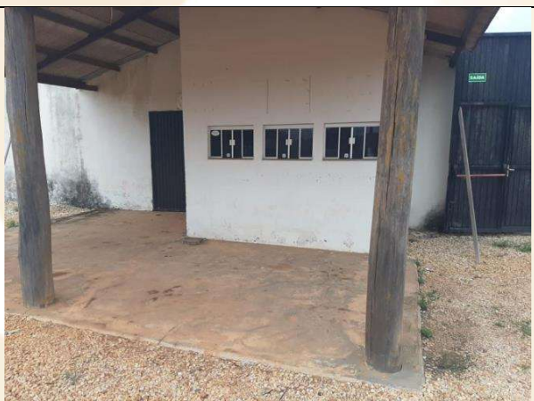
Imagem 06 – Visita “ in loco ”.
