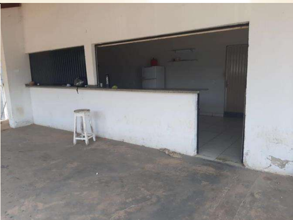
Imagem 08 – Visita “ in loco ”.
