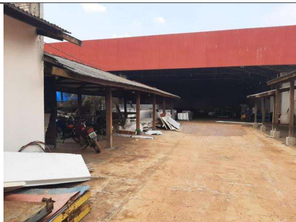
Imagem 03 – Visita “ in loco ”.
