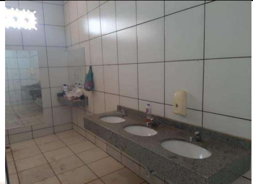
Imagem 22 – Visita “ in loco ”.
