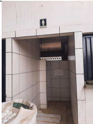
Imagem 19 – Visita “ in loco ”.
