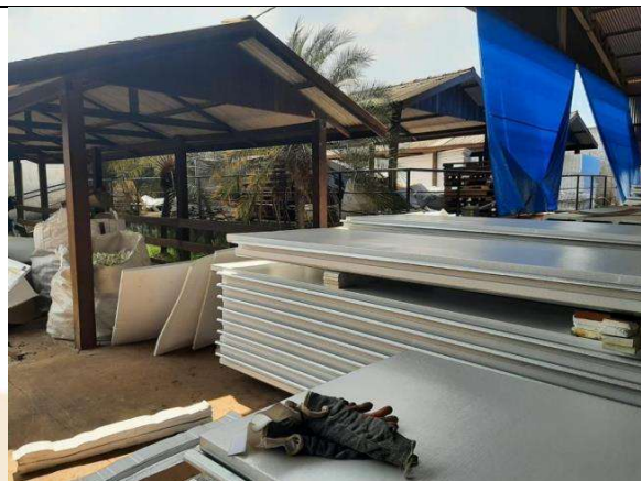
Imagem 10 – Visita “in loco”.
