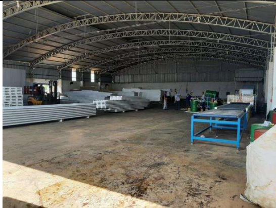
Imagem 15 – Visita “ in loco ”.
