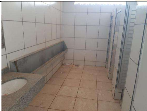
Imagem 23 – Visita “ in loco ”.
