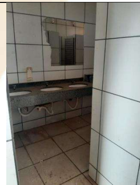
Imagem 24 – Visita “ in loco ”.
