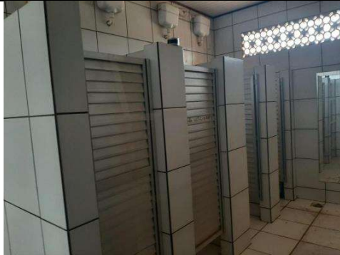
Imagem 21 – Visita “ in loco ”.
