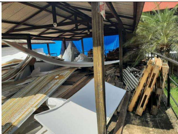
Imagem 11 – Visita “in loco”.
