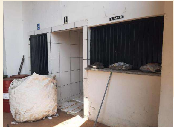
Imagem 20 – Visita “ in loco ”.
