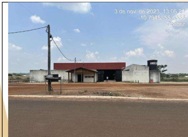
Imagem 01 – Visita “ in loco ”.
