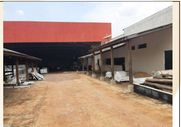
Imagem 02 – Visita “ in loco ”.
