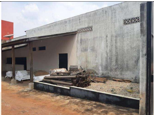
Imagem 04 – Visita “ in loco ”.
