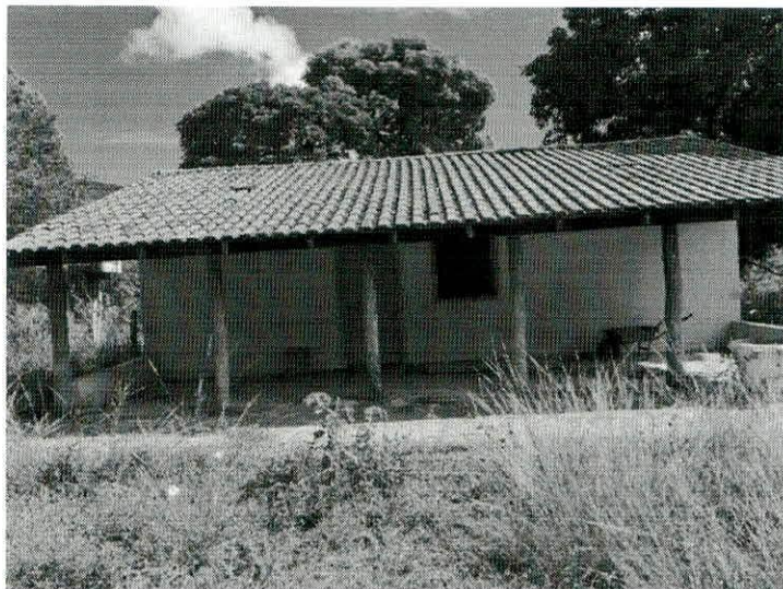
Foto 5 – Edificação da sede desabitada
